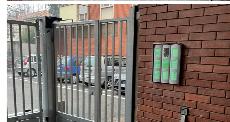
Alcune immagini del cancello e dei citofoni esterni realizzati in via Magenta
